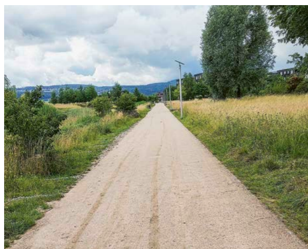
Der Bakisaweg im Griespark ist noch einfacher begeh- und befahrbar dank eines neuen Belags
