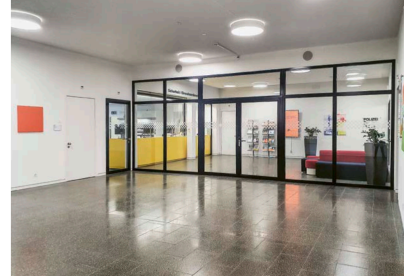
Nach Umbau: Die Glastrennwand schafft einen geschützten Raum vor den Einwohnerdiensten
