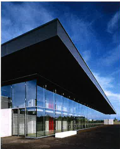
Abb. 1, Glasfassade mit Dachauskragung
